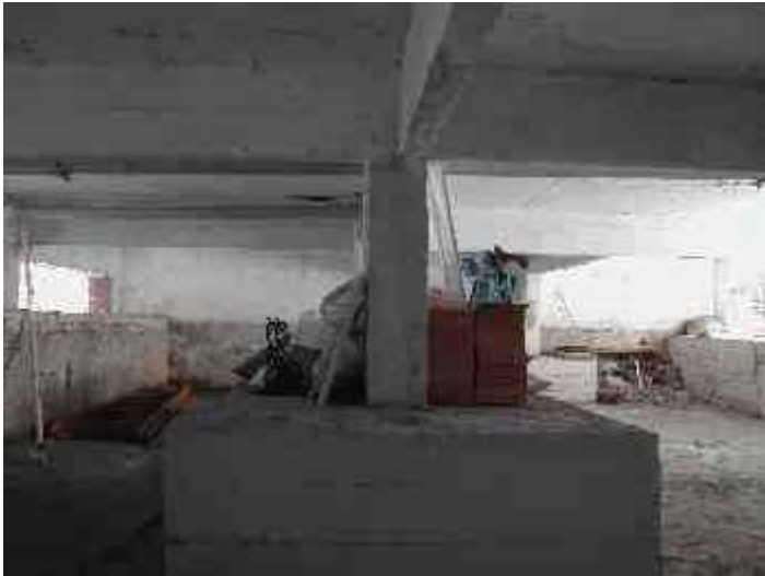
Figura 61 – Área reservada para a construção de depósitos
