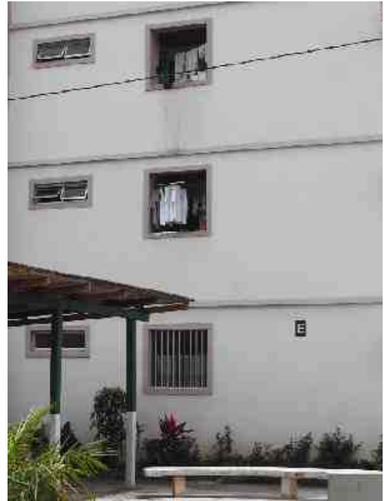
Figura 41 – Vista das aberturas de ventilação das áreas de serviço dos apartamentos
