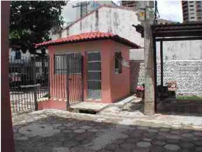
Figura 47 – Vista da antiga portaria e atual vestiário dos porteiros
