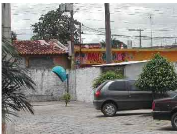
Figura 38 – Abrigo para armazenar lixo e área reservada para a futura portaria, administração e depósito
