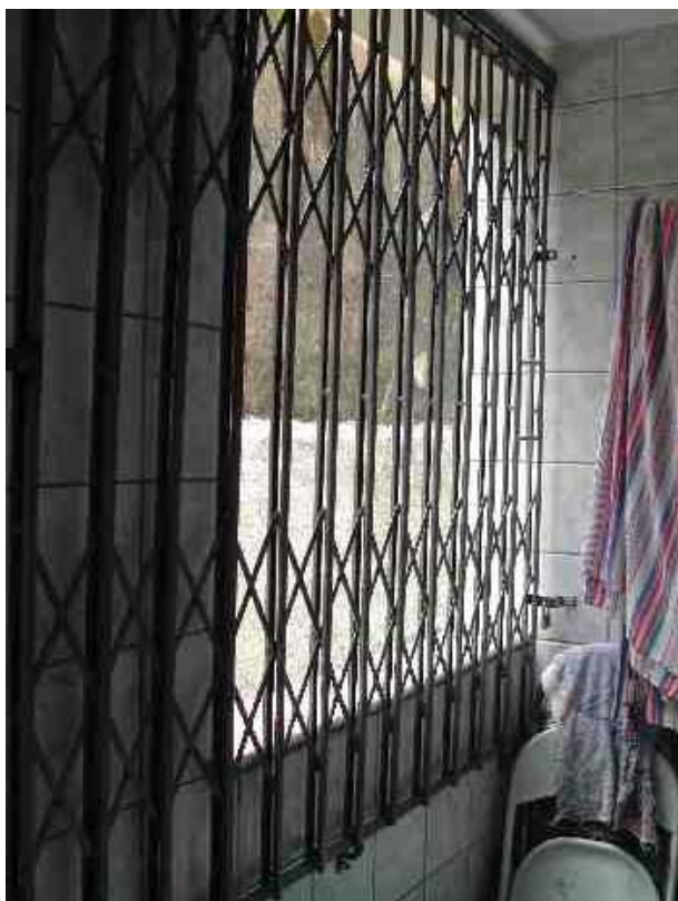
Figura 52 – Adequação da área de serviço de um apartamento térreo para impedir a entrada de terceiros
