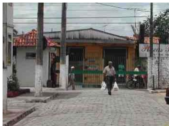
Figura 39 – Vista de portaria, entrada de pedestres e veículos
