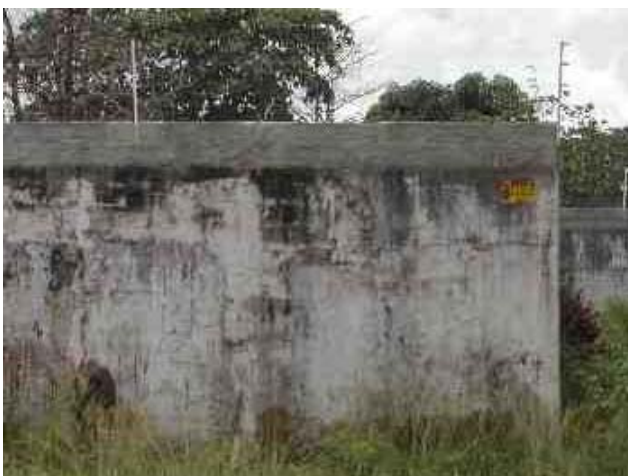
Figura 42 – Vista da cerca elétrica e da elevação da altura do muro
