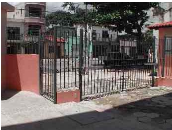
Figura 49 – Portões de acesso para pedestres e veículos
