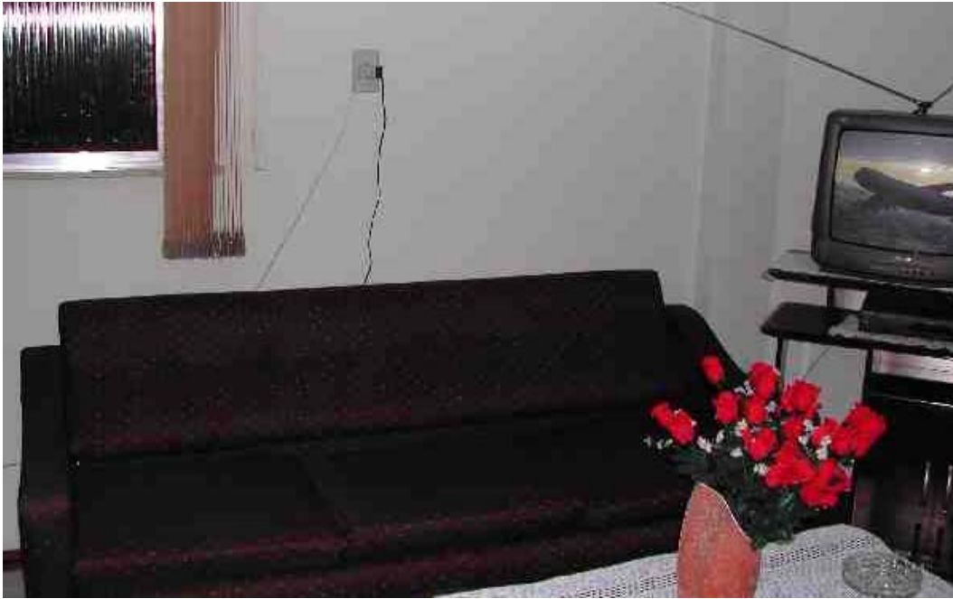
Figura 56 – Exemplo de tomada na sala mal localizada e em quantidade insuficiente
